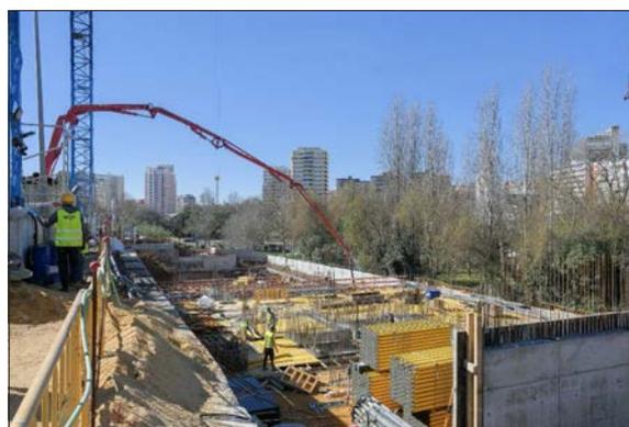
Con PumpSlick se reduce la presión del hormigón en la bomba y en los tubos. Se mejora sustancialmente la fluidez de los hormigones densos.
