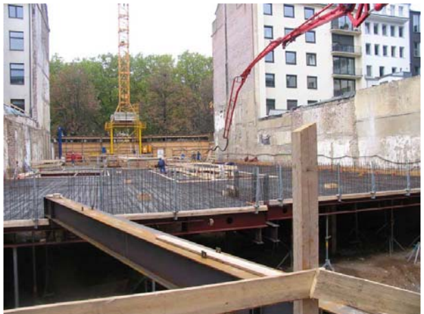
6. Entonces se puede empezar a bombear sin riesgos ni desperdicios.
