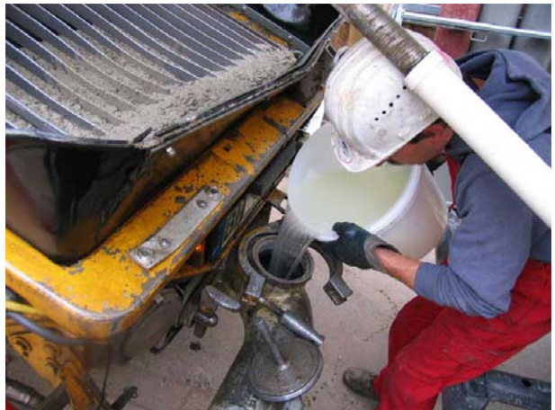
4. Verter el lubricante en el registro de la tobera...
