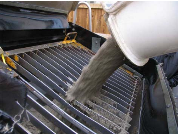
3. Llenar la bomba con el hormigón.
