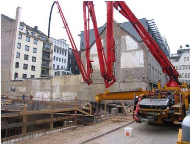
1. Se despliega la trompa de la bomba.
